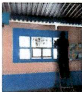
Foto 1: Cambio de ventanas de Madera por material de pvc.
